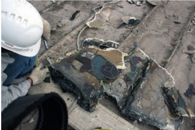
Foto: Recuperando piezas dañadas en obra.
