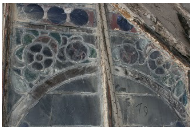
Foto: Vitrales antiguos a sacar de la estructura y retirar.
