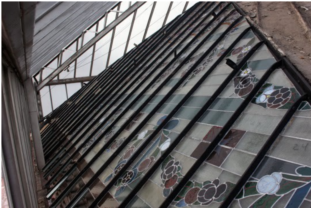
Foto: Vista superior de segmento de las estructura de hierro paneles restaurados.
